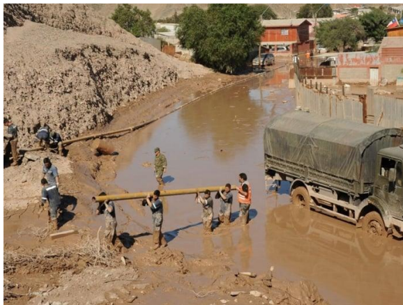
Figura 17. Labores de despeje de calles, caminos y accesos.
