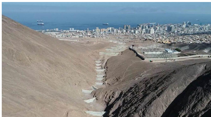
Figura 14. Infraestructura resistente para aluviones
