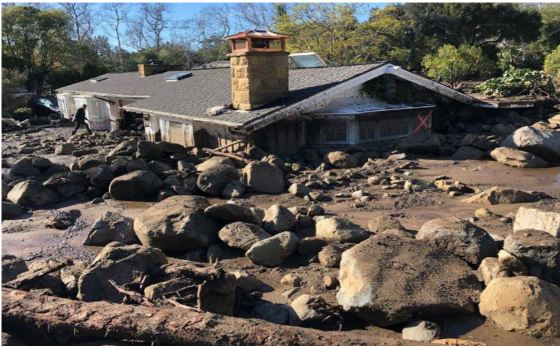
Figura 34. Resultado por aluviones y deslizamiento.
