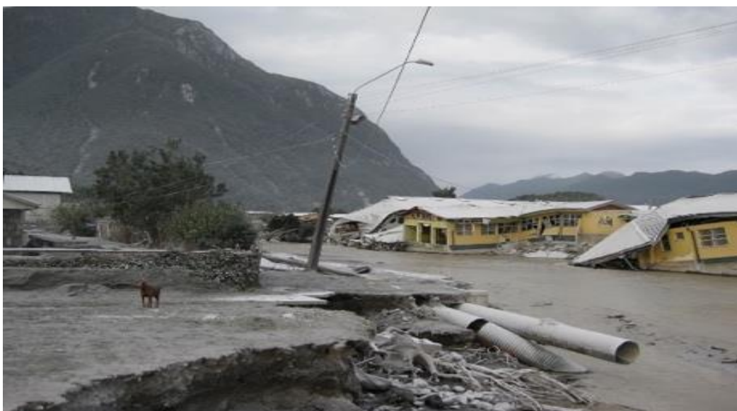
Imagen 13. Daños provocados por el desborde del Río Blanco consecuencia de la erupción
