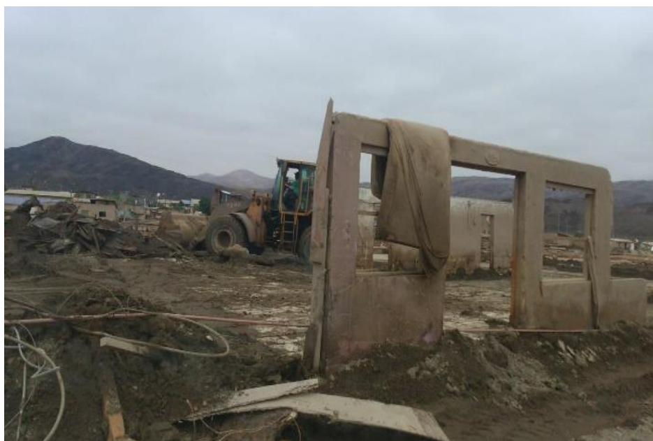
Imagen N.º 07: “Infraestructura devastadas por el aluvión, Diego de Almagro, marzo 2015”.
